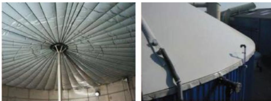
Vue intérieure et poteau central (gauche) – Vue extérieure (droite)
